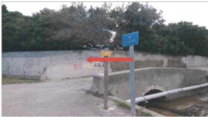
Ouvrage au dessus du ruisseau
