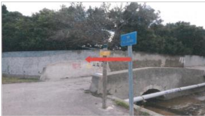
Ouvrage au dessus du ruisseau
