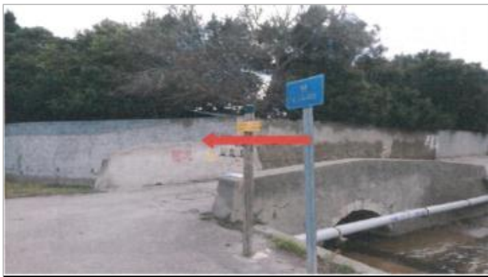
Ouvrage au dessus du ruisseau
