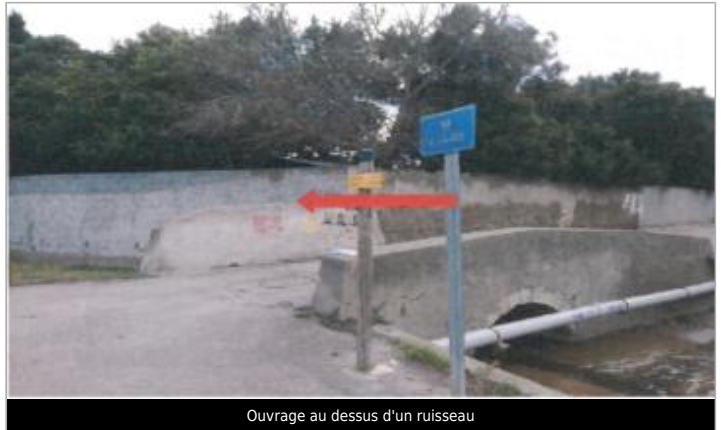
Ouvrage au dessus d'un ruisseau
