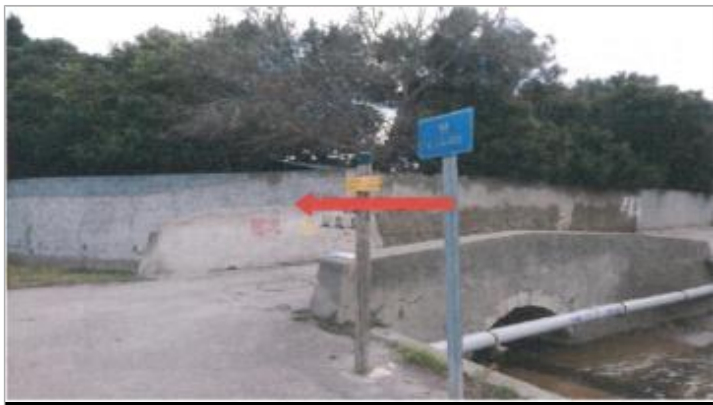
Ouvrage au dessus du ruisseau
