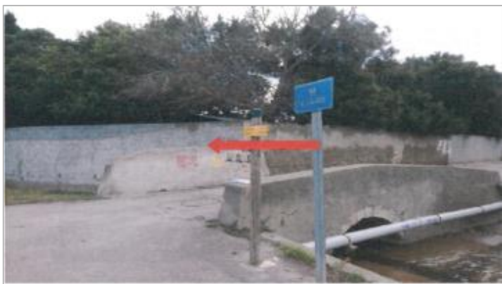
Ouvrage au dessus du ruisseau
