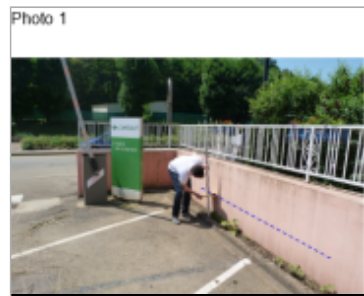
Trace du maximum de la crue sur le muret de clôture du parking du super marché du 23 rue de Metz
