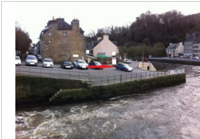
vue générale du quai surcouf, parking et bar
