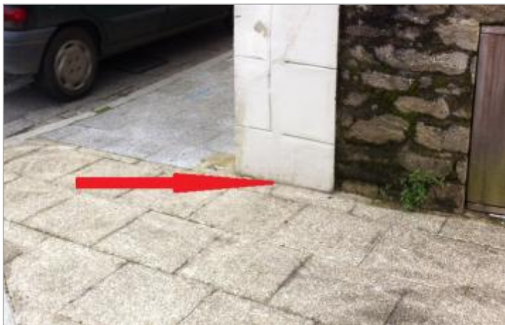
Mur du conservatoire de musique et de danse à l'angle de la rue Bremonds d'Ars et de la place des anciennes fonderies
