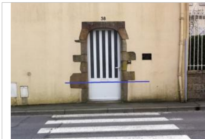
porte d'entrée au 38 rue Bremond d'Arz
