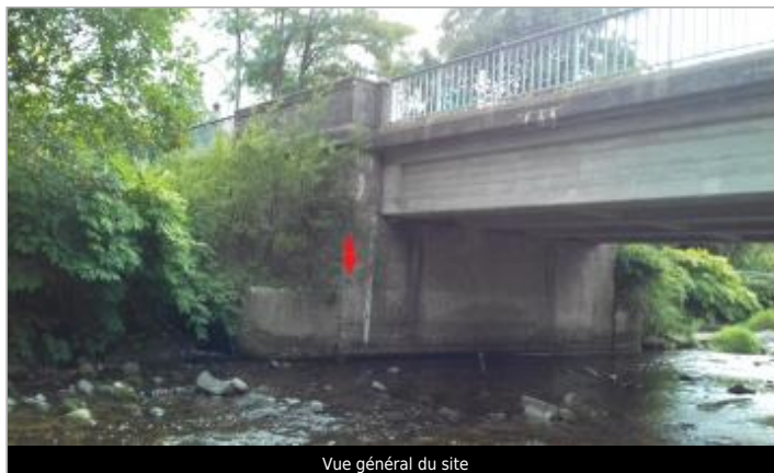
Vue général du site
