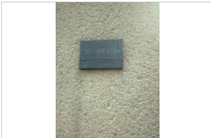
Plaque en ardoise gravée 29 janvier 1995 avec trait du niveau de crue
