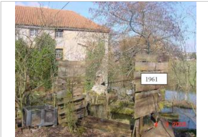
Vue du site
