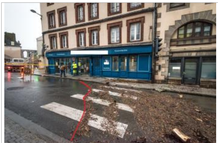
Laisse de crue au sol sur passage piéton
