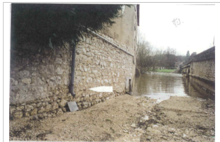
Vue du repère (source : CETE Normandie-Centre)
