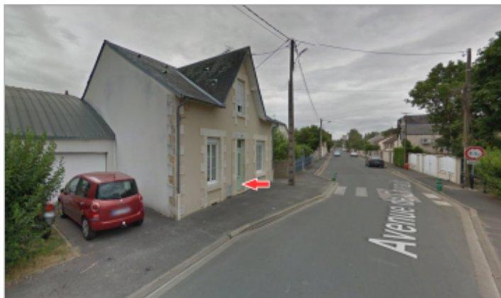
Vue du site (source : Google Street View, juillet 2016)
