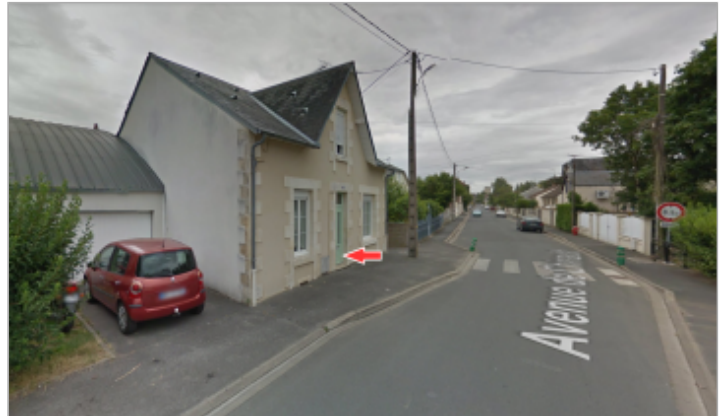
Vue du site (source : Google Street View, juillet 2016)
