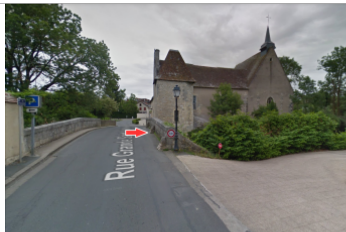
Vue du site (source : Google Street View, juillet 2016)
