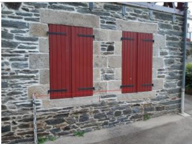
Laisse de crue sur volets à l'arrière du bâtiment
