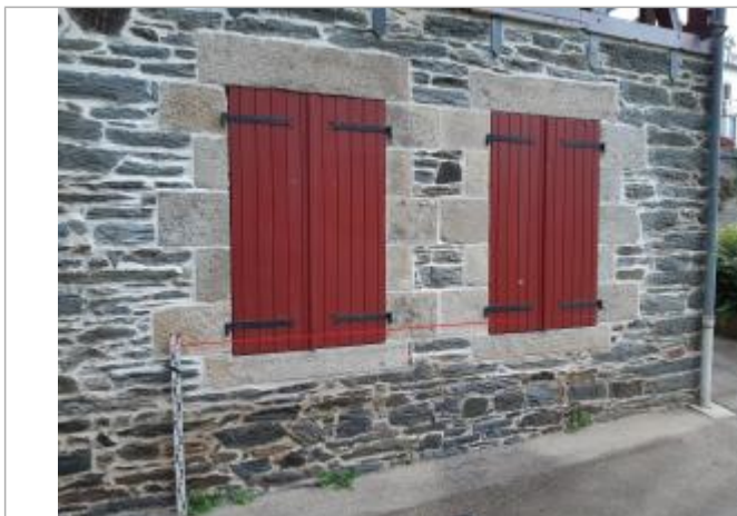
Laisse de crue sur volets à l'arrière du bâtiment
