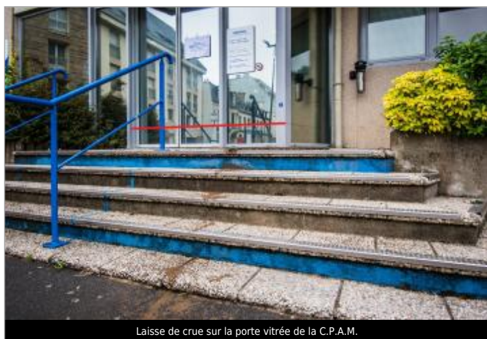
Laisse de crue sur la porte vitrée de la C.P.A.M.
