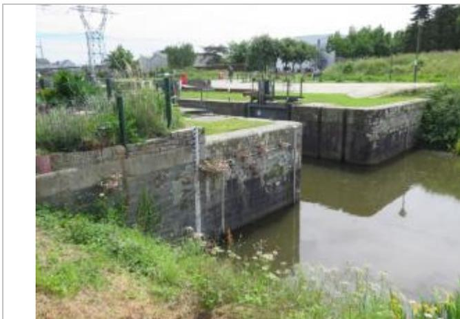
Echelle limnimétrique à l'aval de l'écluse du Comte à Rennes
