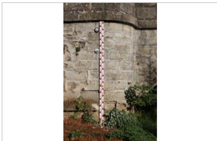
repère correspondant au niveau atteint par la crue du 22/10/1933 (macaron du haut sur la photo)
