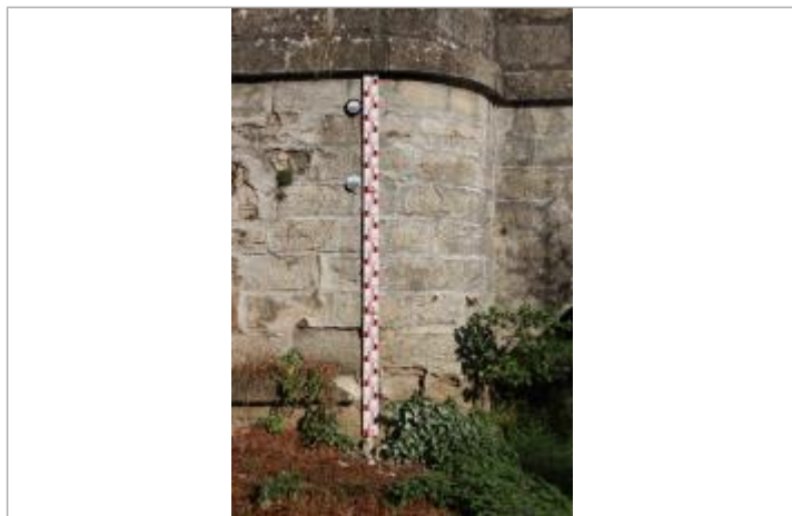
repère correspondant au niveau atteint par la crue du 26/10/1979 (macaron du bas sur la photo)
