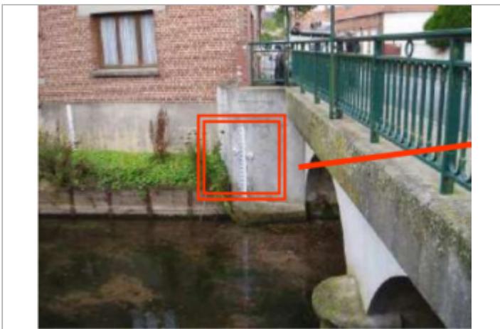
Pont de la rue Jonnart
