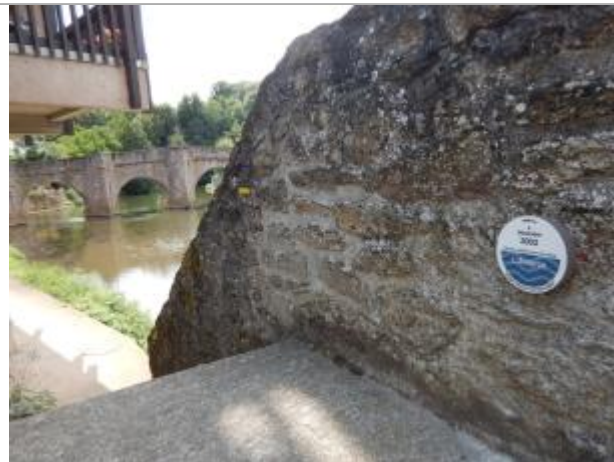
RA-8 : l'Aveyron place de la Mairie (mûr escalier d'accès aux berges)
