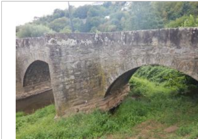
RA-5 : l'Aveyron au niveau du pont de Layoule
