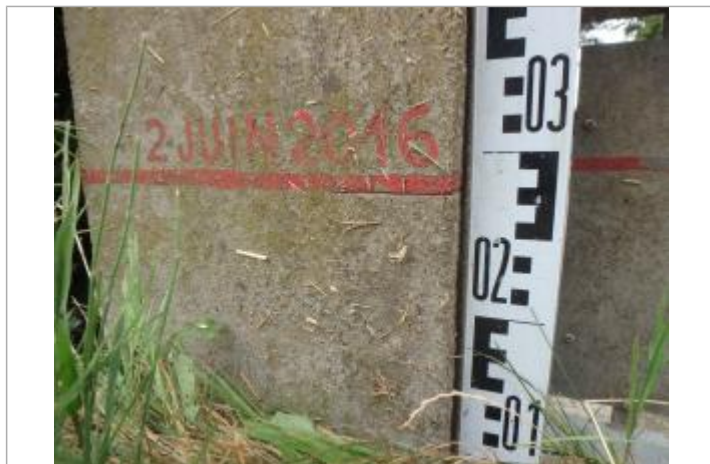
support pile de portail
