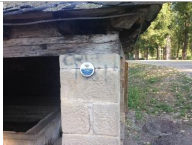
MONT-1 : Lavoir de Monteils
