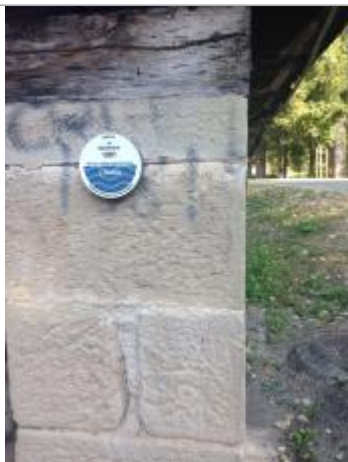
Repère du niveau atteint par la crue du 14 décembre 1981
