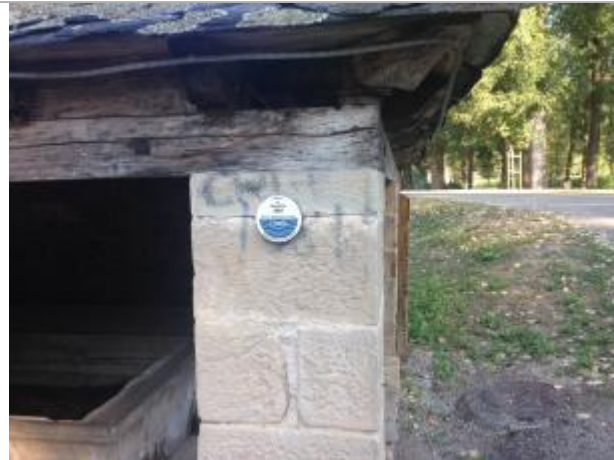
MONT-1 : Lavoir de Monteils
