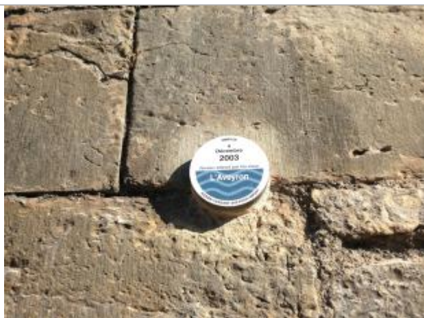
repère correspondant au niveau atteint par la crue du 04/12/2003 (macaron du bas)
