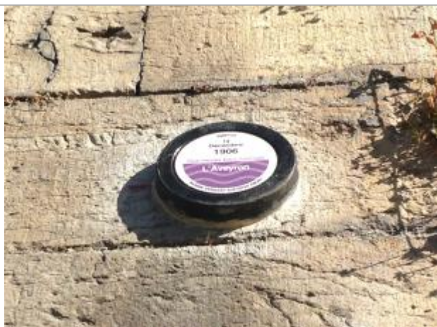
repère correspondant au niveau atteint par la crue du 14/12/1906 (macaron le plus haut)
