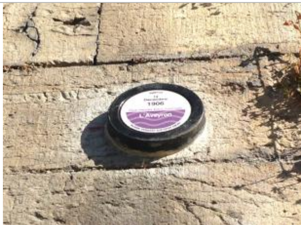
repère correspondant au niveau atteint par la crue du 14/12/1906 (macaron le plus haut)
