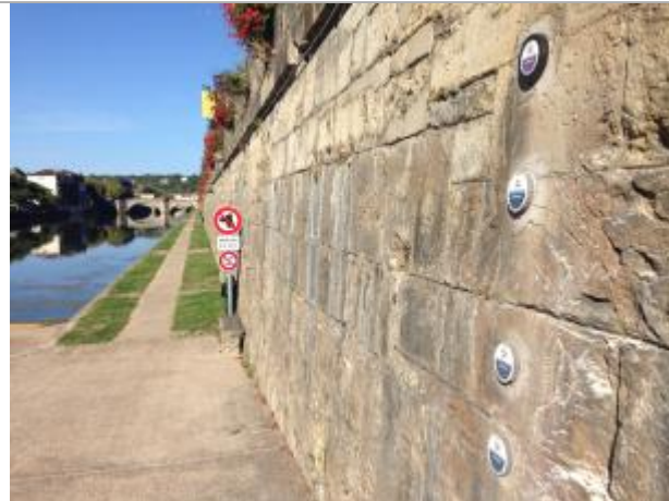
VDR-2 : echelle de crues des Bains Douches
