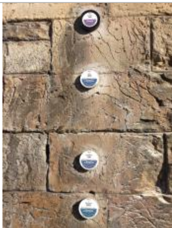
repère correspondant au niveau atteint par la crue du 14/12/1981 (2ème macaron en partant du bas sur la photo)
