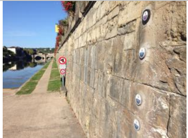
VDR-2 : échelle de crues des Bains Douches
