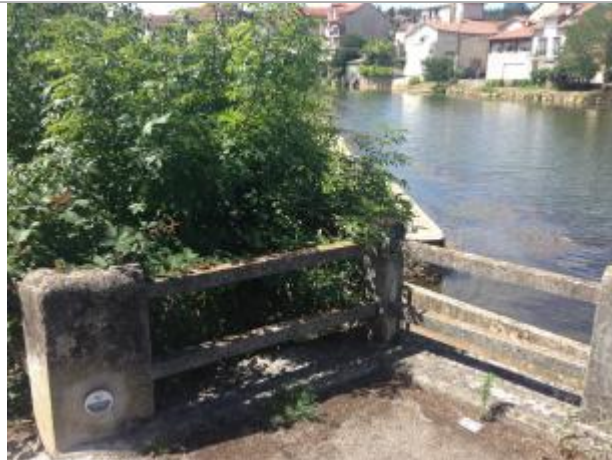
L'Aveyron au niveau du Quai Adolphe Poult, au dessus de la passe à poissons
