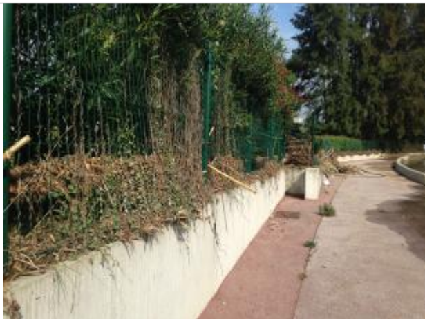
Repère du niveau atteint par la crue du 4 octobre 1961
