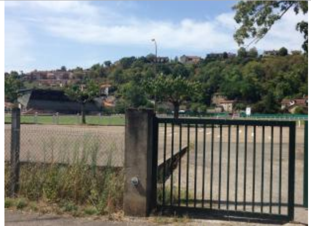
VDR-6 : pilier du portail de l'entrée Est du complexe sportif du Teulel
