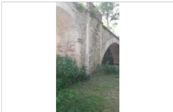
MONT-3 l'Aveyron au pont de Floirac (RD 648) - crue du 14 décembre 1981
