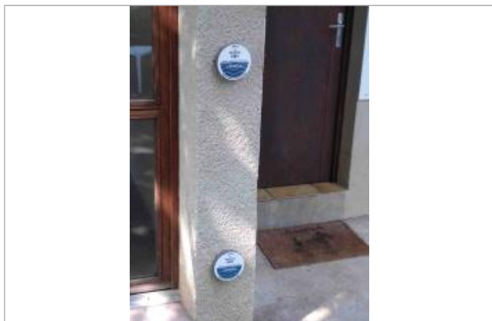
COMP-2 l'Aveyron au niveau du bâtiment d'accueil du camping (repère haut)
