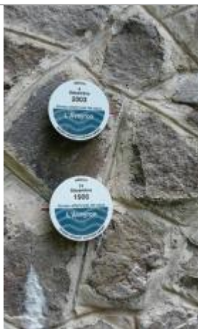
LOUB-1 : l'Aveyron à La Loubière (pont RD563) - crue du 14 décembre 1906
