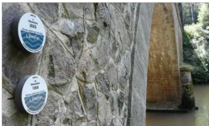
LOUB-1 : L'Aveyron à La Loubière (pont RD563) - crue du 4 décembre 2003
