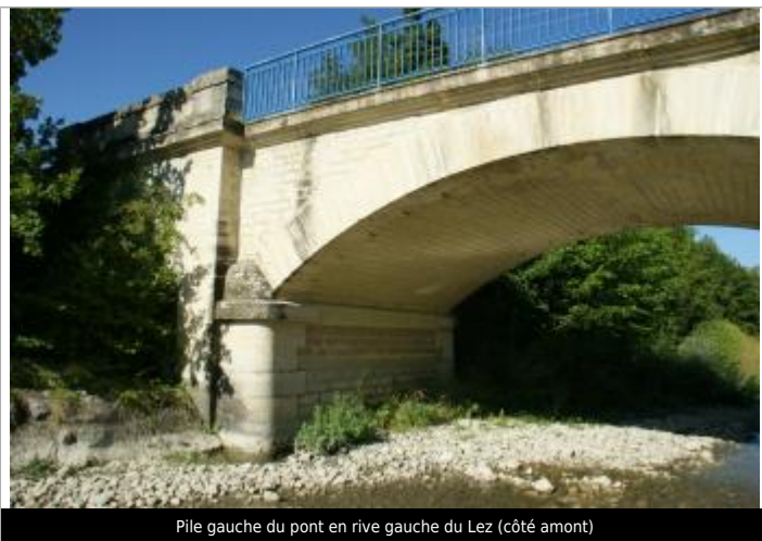
Pile gauche du pont en rive gauche du Lez (côté amont)
