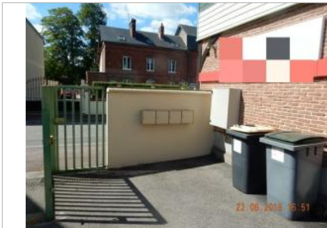
Vue du mur du portail à l'intérieur du parking (photo SPC SACN)
