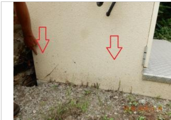
Laisses d'inondation sur le transformateur (photo SPC SACN)
