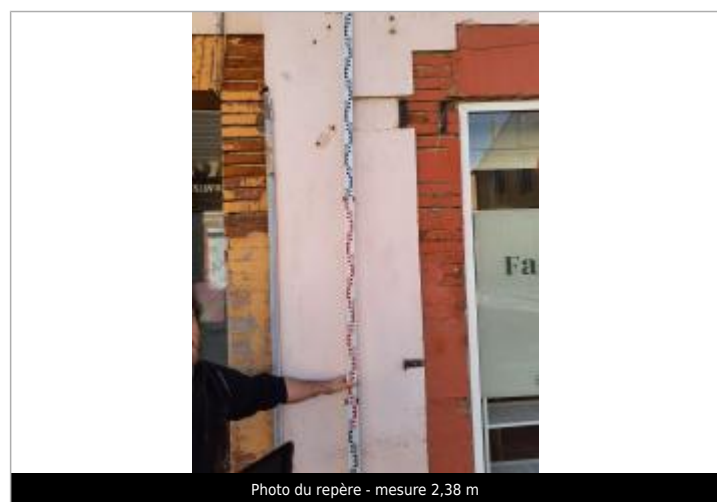
Photo du repère - mesure 2,38 m
