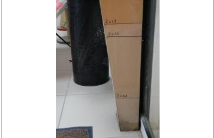
Reperes de crue 2001-2016-2018
