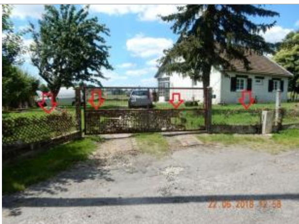
Laises d'inondation sur le grillage (photo SPC SACN)
