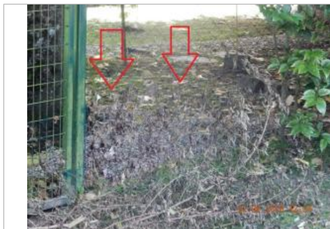
Laises d'inondation sur le grillage (photo SPC SACN)
