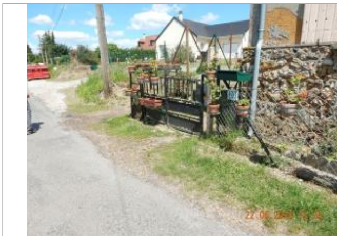
N°20 rue du Bas Ruel (photo SPC SACN)
