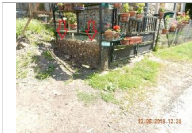
Laiesses d'inondation sur le grillage (photo SPC SACN)
