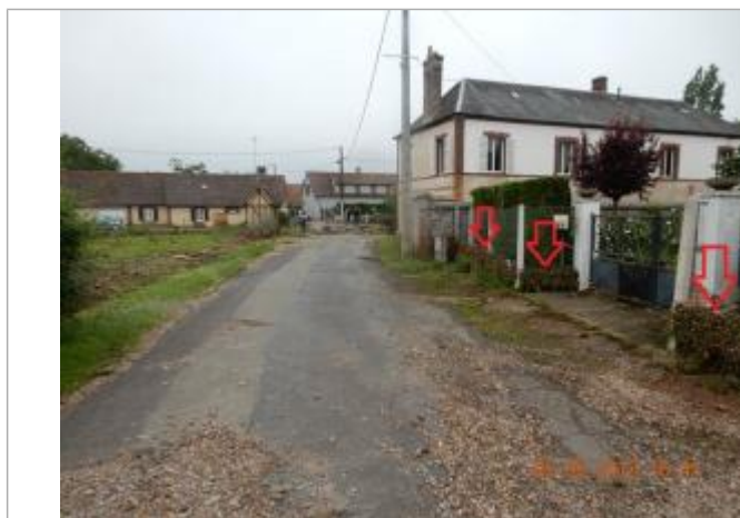
Laisses d'inondation sur le grillage (photo SPC SACN)
