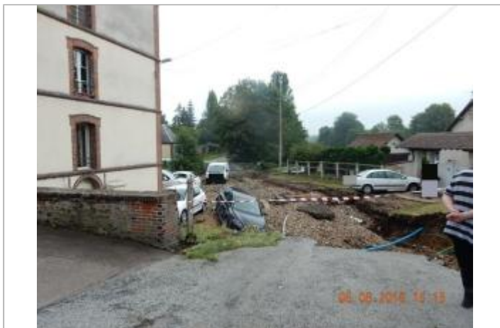
Rue du moulin vers l'aval (photo SPC SACN)
