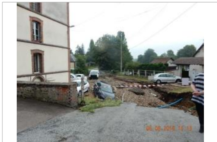
Dégâts générés par le débordement de l'Iton (photo SPC SACN)
