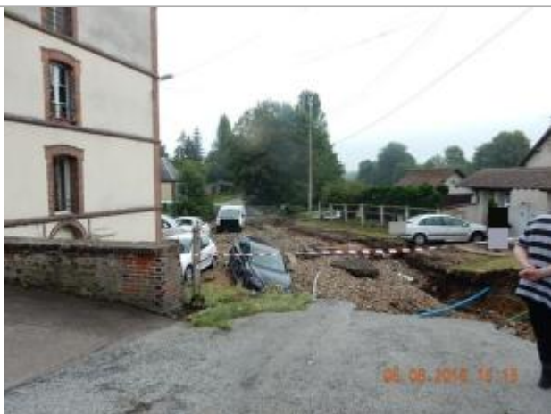
Dégâts générés par le débordement de l'Iton (photo SPC SACN)
