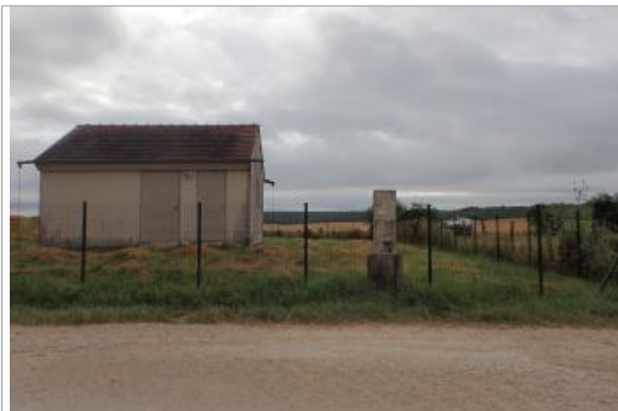
Station de pompage des eaux - photo SMBVA 2016 (c)
